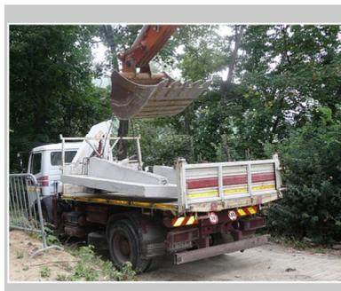
Questo dovrà essere eseguito con particolare attenzione e cura ai carichi sospesi utilizzando idonee funi o catene dotate di ganci di sicurezza e con angolo di tiro non inferiore a 60°.
