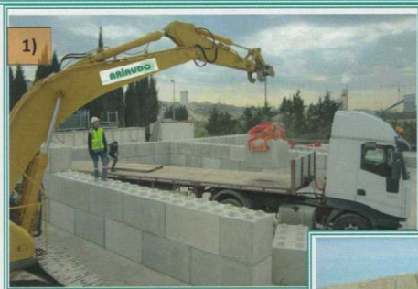
Foto 1) - 2) - 3) Grazie alla loro caratteristica di modularità, peso e le sporgenze sulla sommità dei blocchi possono essere impilati come meglio Vi occorre senza bisogno di alcun materiale legante.
