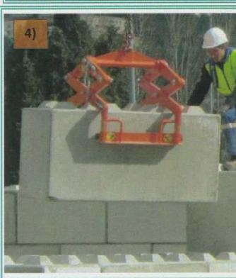
Foto 4) Semplicità di montaggio anche grazie all'ausilio di pinza (accessorio) per il sollevamento e il posizionamento del manufatto.
