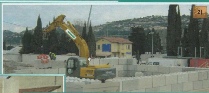
Foto 1) - 2) - 3) Grazie alla loro caratteristica di modularità, peso e le sporgenze sulla sommità dei blocchi possono essere impilati come meglio Vi occorre senza bisogno di alcun materiale legante.
