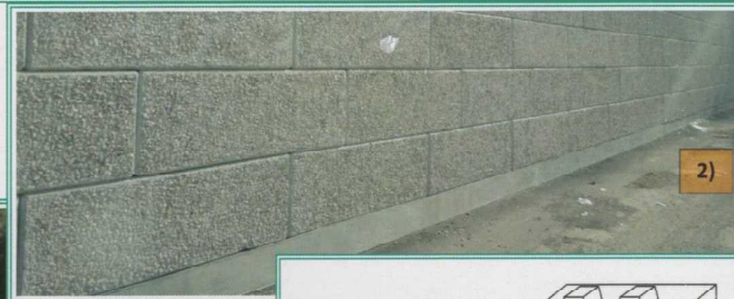
Foto 1) - 2) - 3) - 4) Alcuni esempi di soluzioni possibili di utilizzo dell'elemento Cement Block (divisori interni capannoni, sostegni terrapieni, dissuasori, silos etc...)
